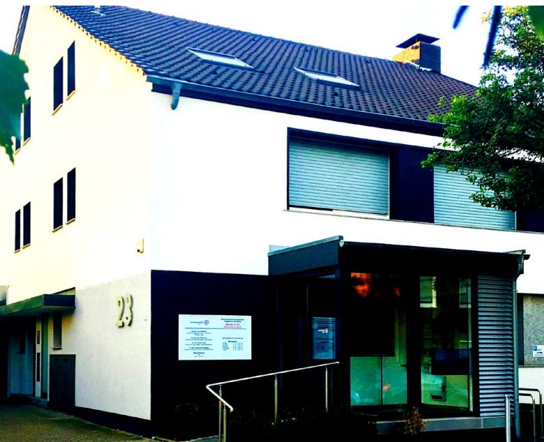
Das MVZ Hausarztzentrum Styrum mit vier Ärzten und sechs Mitarbeiterinnen ist an der Alvenslebenstraße 23 zu finden. Foto: MVZ
